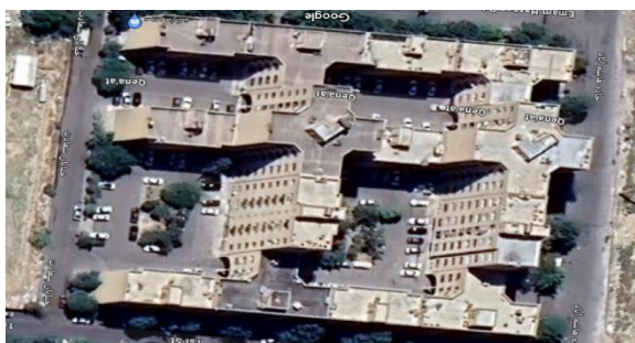
تصویر (۱)-عدم تناسب عرض راهها با ارتفاع و حجم تعداد افراد تخلیه شونده در ساختمان‌ها
